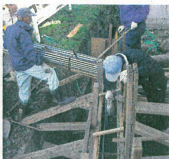
水路の自力施工
